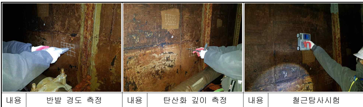
【사진 12.57】 지도능곡 재료시험 전경
